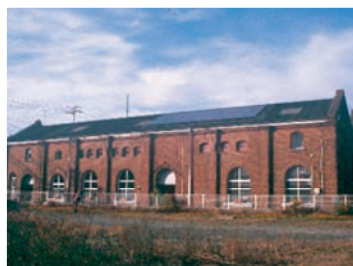
旧三川電鉄変電所
