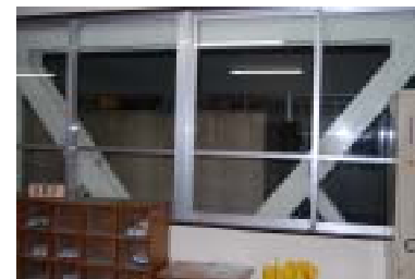
耐震補強工事
