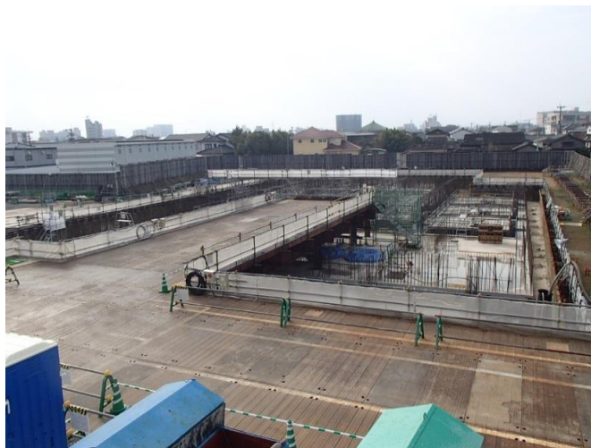
地下構造物工事
