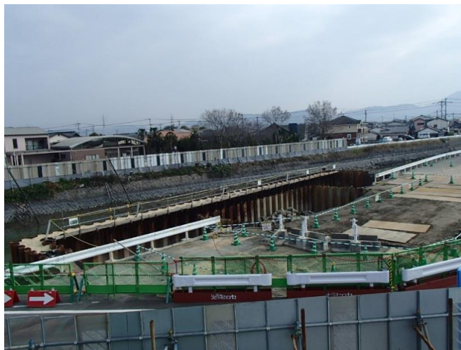
放流きょ工事
