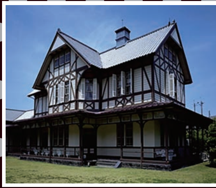
きゅうみついみなとくらぶ 旧三井港倶楽部
