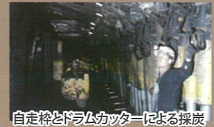
自走枠とドラムカッターによる採炭
