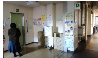
エレベーターの位置が分かりにくい
