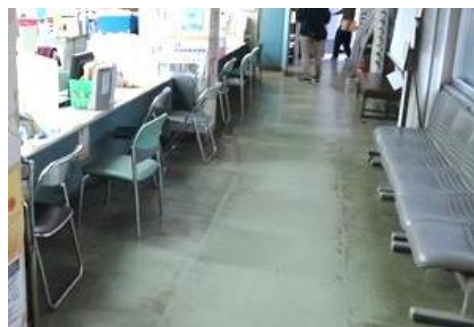
廊下に窓口・待合スペースがありプライバシーの確保や人・車椅子の通行に支障がある
