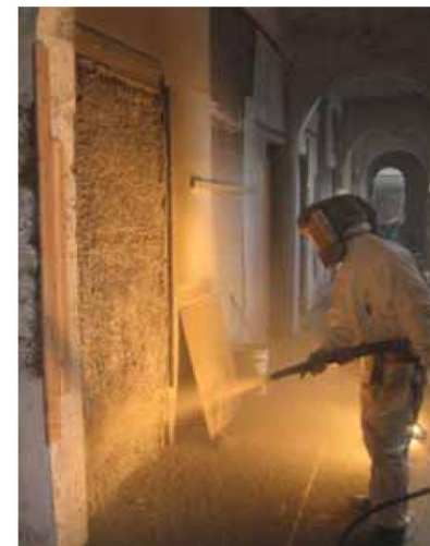
吹付けコンクリート施工
