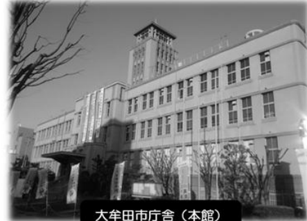
大牟田市庁舎(本館)
