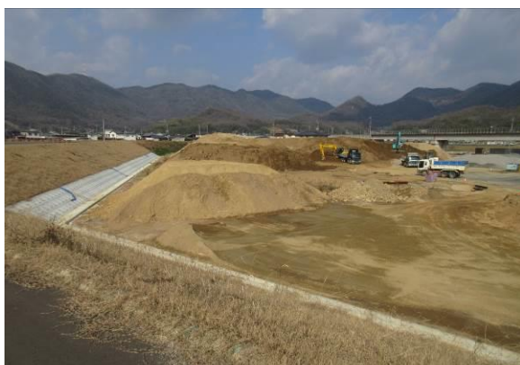
あちこちで、堤防決壊箇所の補修・堤防の補強・河川の浚渫・付け替え工事が行なわれている。
