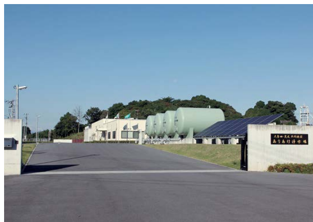
ありあけ浄水場
