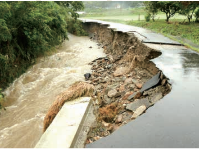
左：広範囲にわたり護岸が崩壊した白銀川（上内） 中：崖崩れが発生し、土砂で埋まった県道5号線（三池：八角目峠） 右：冠水し、私有地との境界がわからなくなった国道208号線（田隈）
