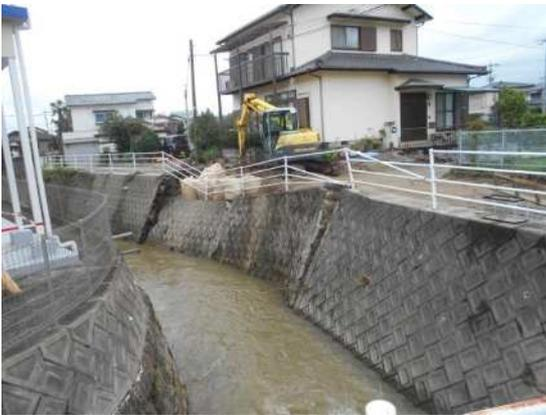
写真 3-1-13 ⑨護岸損傷（堂面川）
