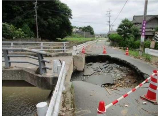
写真 3-1-9 ⑤道路兼用護岸崩壊・陥没
