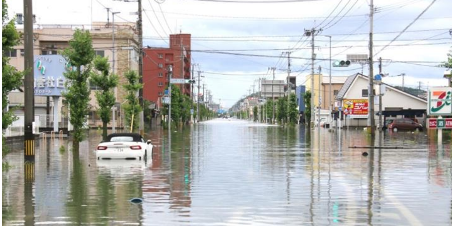
国道389号線(三川地区)冠水
