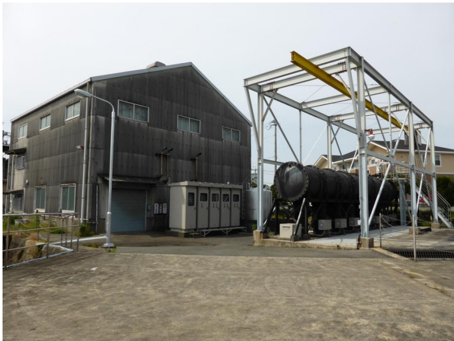
三川ポンプ場
