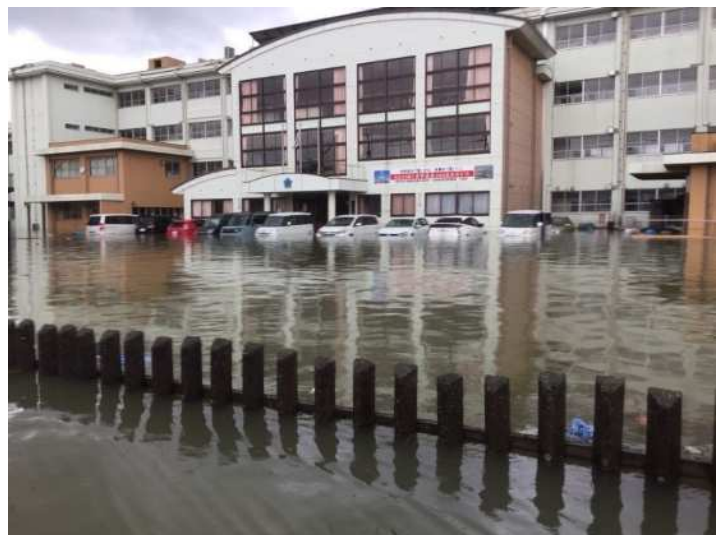
写真 3-1-2 ②みなと小学校浸水（令和 2 年 7 月 7 日）
