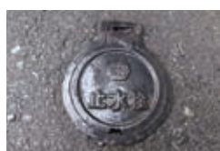
直結止水栓 (メーターボックス)
