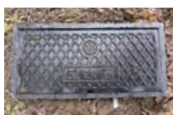
直結止水栓 (メーターボックス)
