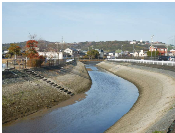
自然保全型護岸の整備
