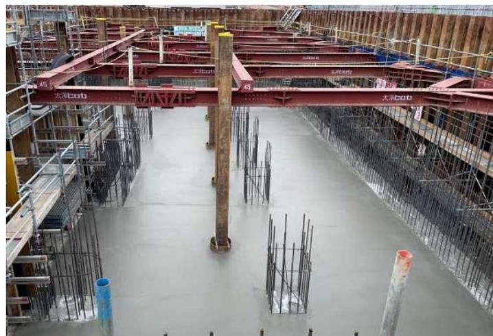
(①ポンプ棟底版コンクリート打設完了状況)
