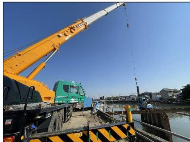
（仮護岸の撤去状況）
