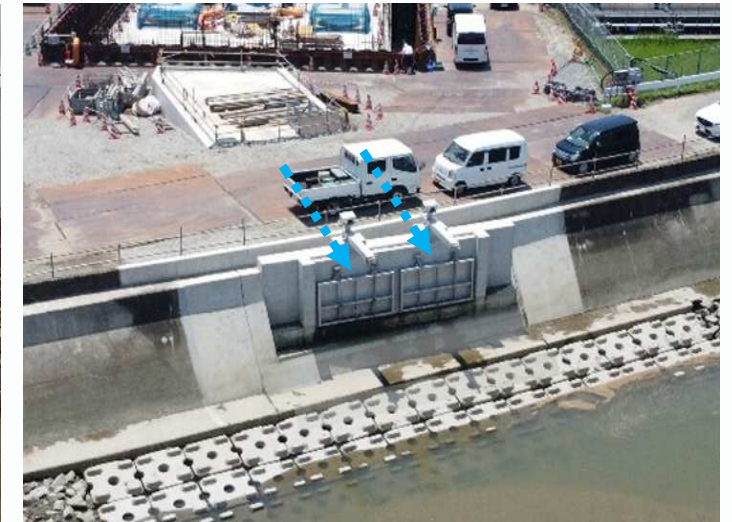
③放流渠・樋門・護床ブロック【完了】
