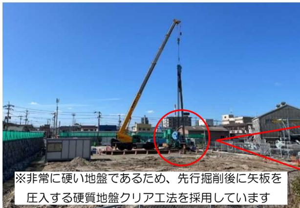
※非常に硬い地盤であるため、先行掘削後に矢板を圧入する硬質地盤クリア工法を採用しています
