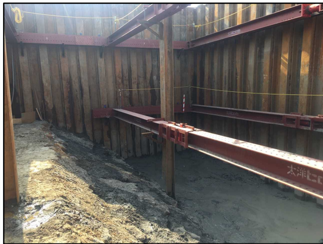
掘削作業完了
