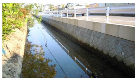
道路改良工事による護岸整備
