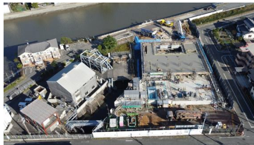
※整備が進む三川新ポンプ場
