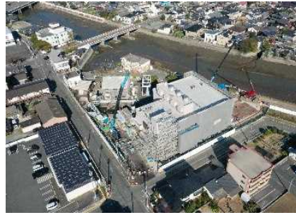
※整備が進む三川新ポンプ場
