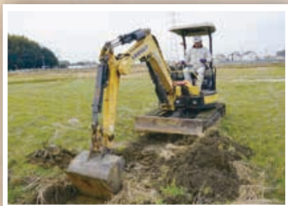
掘った土の表面が観察できるように、ショベルカーは爪のないものを使用します
