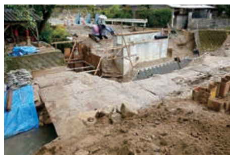
橋梁 復旧途中
