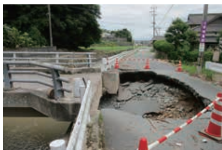
橋梁 被災直後
