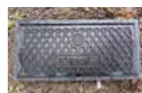
直結止水栓 （メーターボックス）
