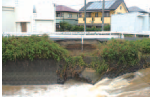
手鎌地区 農業用施設 (井堰)
