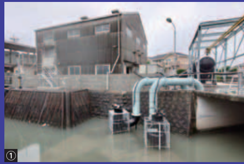
①三川ポンプ場のポンプを2基増設 ②浸水対策として行われた三川ポンプ場の電気設備のかさ上げ ③三川新ポンプ場の完成予想図。現在の位置に隣接した樋口公園に建設される予定
