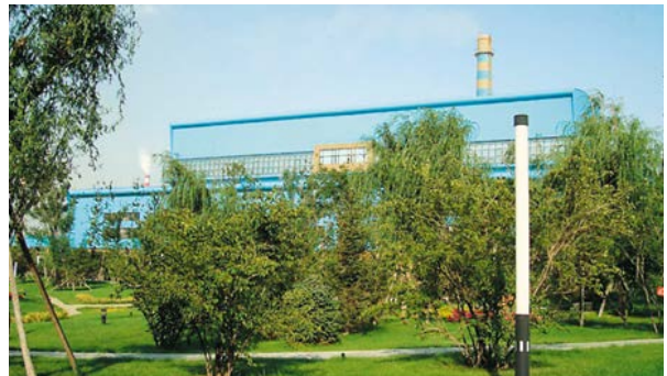
ごみ焼却処理発電工場
