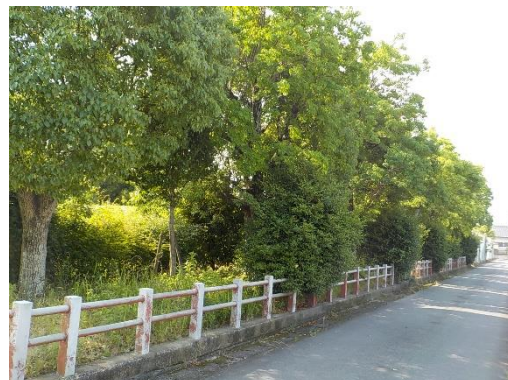
外部からの見通しを阻害している樹木
