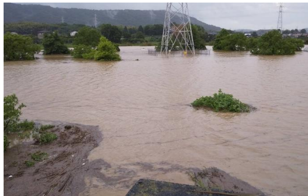
白銀川調節池公園 (令和2年7月豪雨災害)
