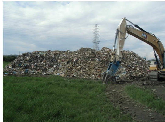
可燃ごみ一破碎後（手鎌北町公園）
