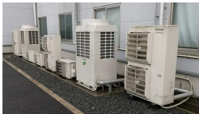
室外機の適切な設置例
