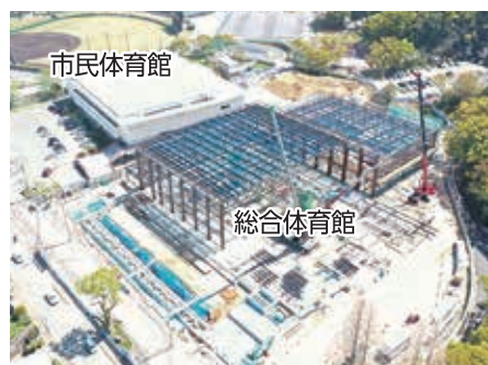
総合体育館建設風景（ドローン撮影3月）
