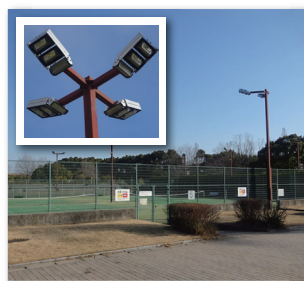
令和 2 年度 諏訪公園テニスコート 照明 L E D 化改修
