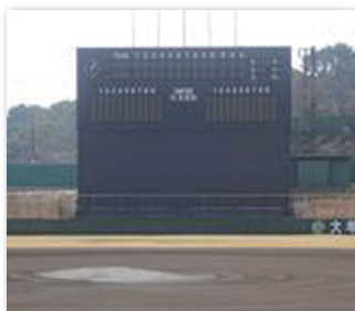
平成 29 年度 延命球場 スコアボード等改修
