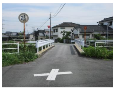
橘中学校南側の橋
