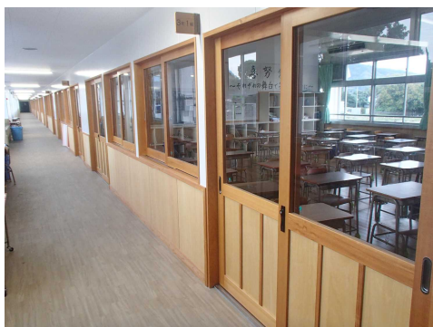
教室の木質化（完成）
