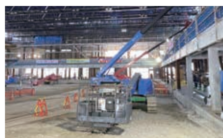
アリーナの内部でもクレーンや高所作業車で工事を行っています
