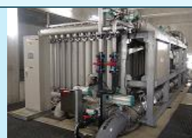
セラミック膜ろ過装置
