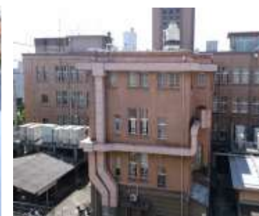
建物の老朽化
