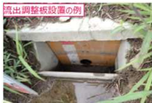
流出調整板設置の例
