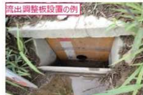
流出調整板設置の例
