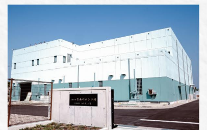
新たなポンプ場も建設
