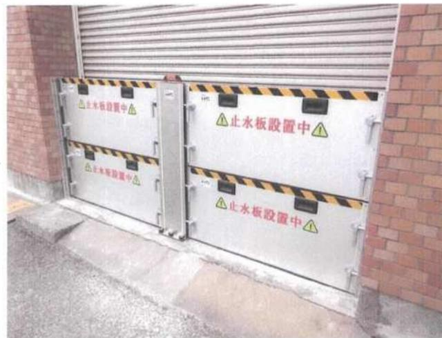
大雨が降ってポンプ場の周りが浸水しても、ポンプ場が浸水することなく稼働できるように止水板の設置や施設の嵩上げを実施しました。
