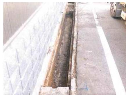
道路の側溝や集水桝に土砂が堆積しすぎると、大雨の際に水はけが悪くなることから土砂等を撤去し、水の流れを良くします。市内には多くの道路側溝や集水桝があるためすべてを定期的に浚渫(土砂撤去)することは難しいですが、市職員が現地を確認し、浚渫を実施しています。
