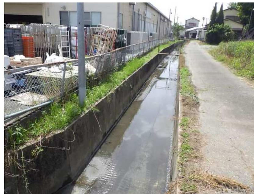
水路に土砂が堆積し、草が繁茂すると流下阻害となるので、土砂等を撤去し、水の流れを良くします。市内には多くの水路があるためすべての水路を定期的に浚渫(土砂撤去)することは難しいですが、市職員が現地を確認し、水路の浚渫を実施しています。近年、地域でのボランティア活動も増えており、大変助けられています。
