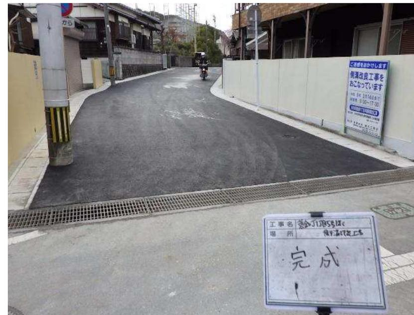
市内には、多くの道路(市道)が整備されていますが、あわせて道路に降った雨を、水路や下水道に排水するための道路側溝が整備されています。しかし、なかには道路側溝が整備されていないものや、蓋などを架設できる構造ではなく老朽化しているものも多く、うまく排水できないことから、道路側溝の改良を進めています。
