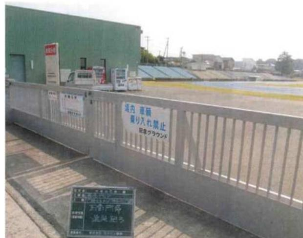
大雨が降ってその水が下流に一気に流れると下流の浸水が大きくなります。一気に流さず少しずつ流すよう記念グラウンドに止水壁やオリフィスなどのオンサイト貯留施設を整備しました。
