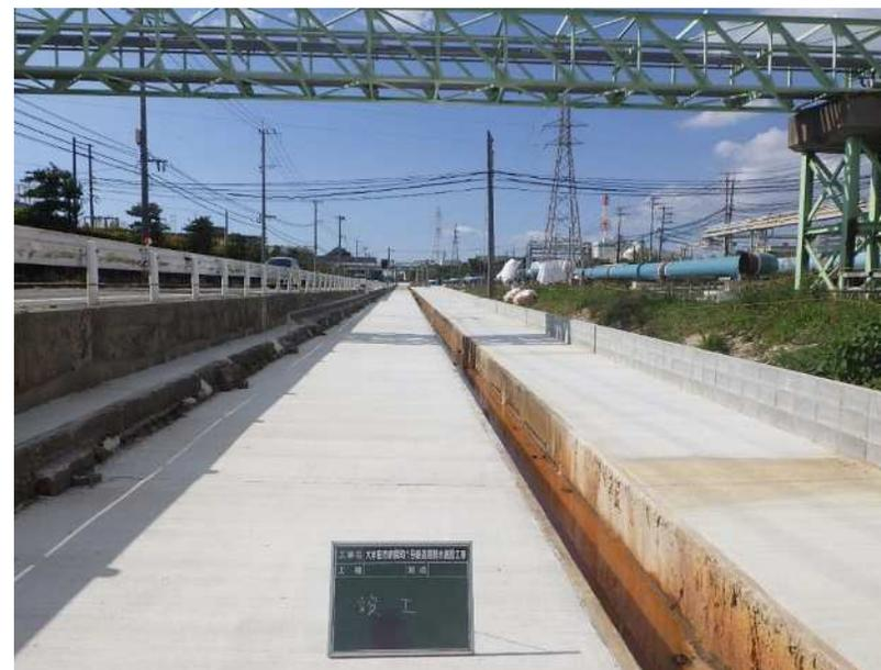
有明海沿岸道路の健老インターチェンジの南にある道路(新開町1号線)は、水路の水はけが悪く、頻繁に道路冠水を引き起こし、交通に大きな影響を与えていました。今回水の流れを良くするために、道路排水の流末である水路を改修しました。
