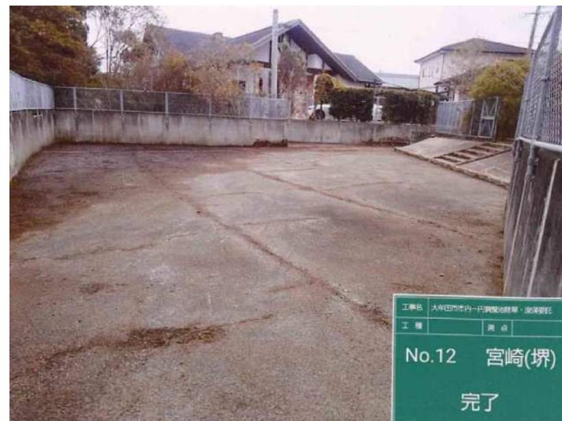
調整池に土砂が堆積し、草が繁茂すると貯留量が減ったり、草がオリフィスに詰まったり管理するうえで支障となるので、土砂等を撤去します。市内には多くの調整池があるためすべての調整池を定期的に浚渫(土砂撤去)することは難しいですが、市職員が現地を確認し、調整池の浚渫を実施しています。
