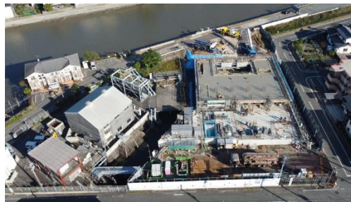
※整備が進む三川新ポンプ場
