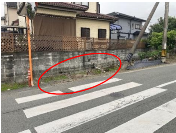
①みさき病院南の道路横の水路
