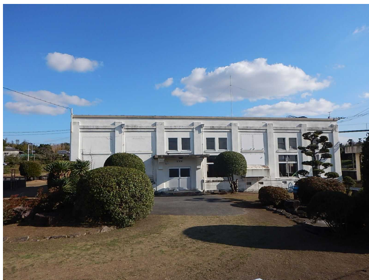
清里総合ポンプ場
