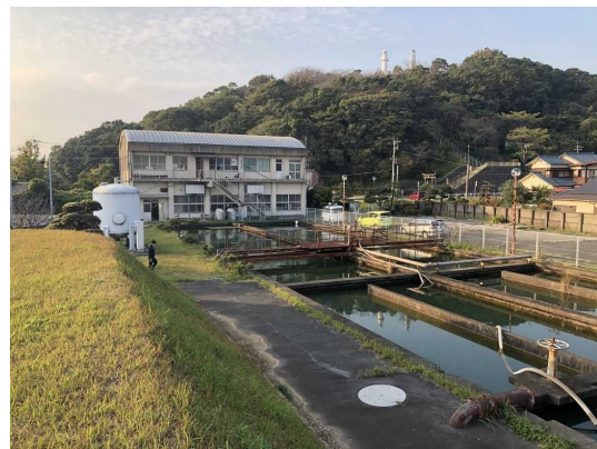
水源センター
