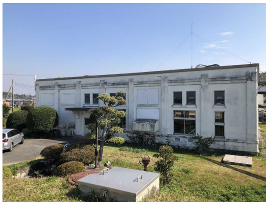
清里総合ポンプ場
