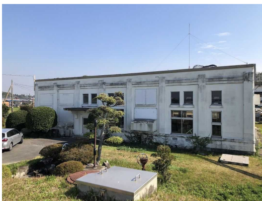
清里総合ポンプ場
