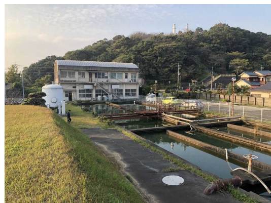
水源センター
