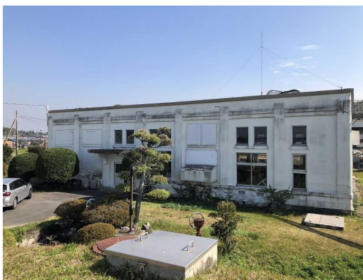
清里総合ポンプ場
