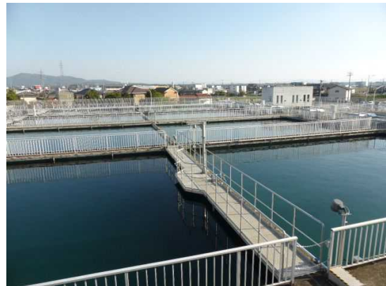
福岡県南広域水道企業団 荒木浄水場
