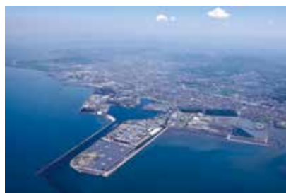
重要港湾 三池港
